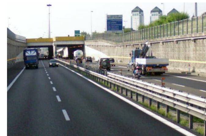
Fig. 5.5.vii – Esempi di trincee coperte con sistemazioni superficiali finalizzate al traffico locale Elaborazione META
